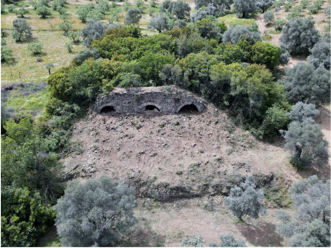
Fig. 12. Roma Hamamı'nın Temizlik Aşamasındaki Görünümü
