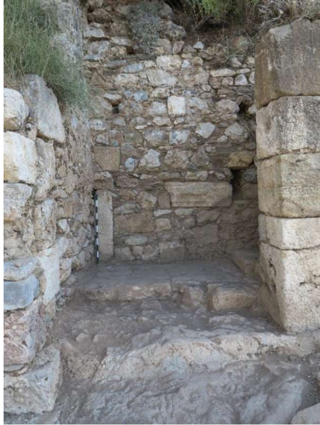
Fig. 4: 1. Sahanlık Bölümü Kazılar Sonrası Görünümü
