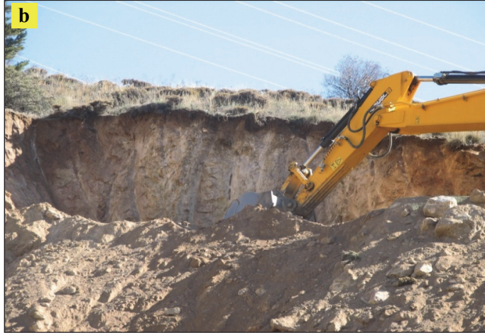
Şekil 8. (a) 1 numaralı alandaki orta derecede, ve (b) 4 numaralı alandaki ileri derecede ayrışmış kaya kütlelerinde yapılan kazı çalışmaları.
