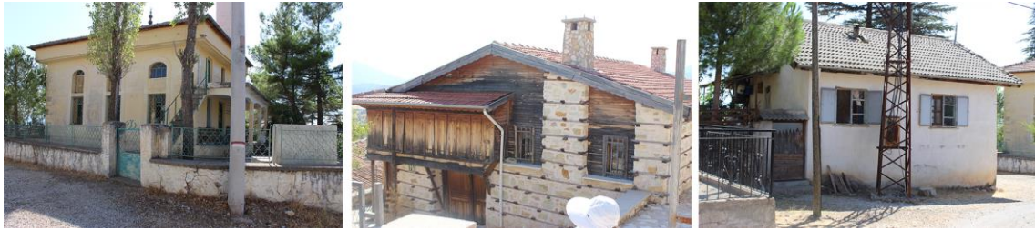
Resim 8. Belenalan köyündeki dokuya uyumlu ve uyumsuz betonarme yapı örnekleri
