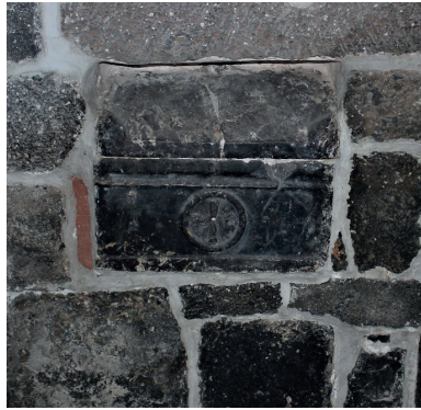
Görsel 23: Diyarbakır Meryem Ana Kilisesi bünyesinde yer alan Mor Yakup Kilisesi'ne ait röliker örnekleri 2 (Evin Telli'den).
