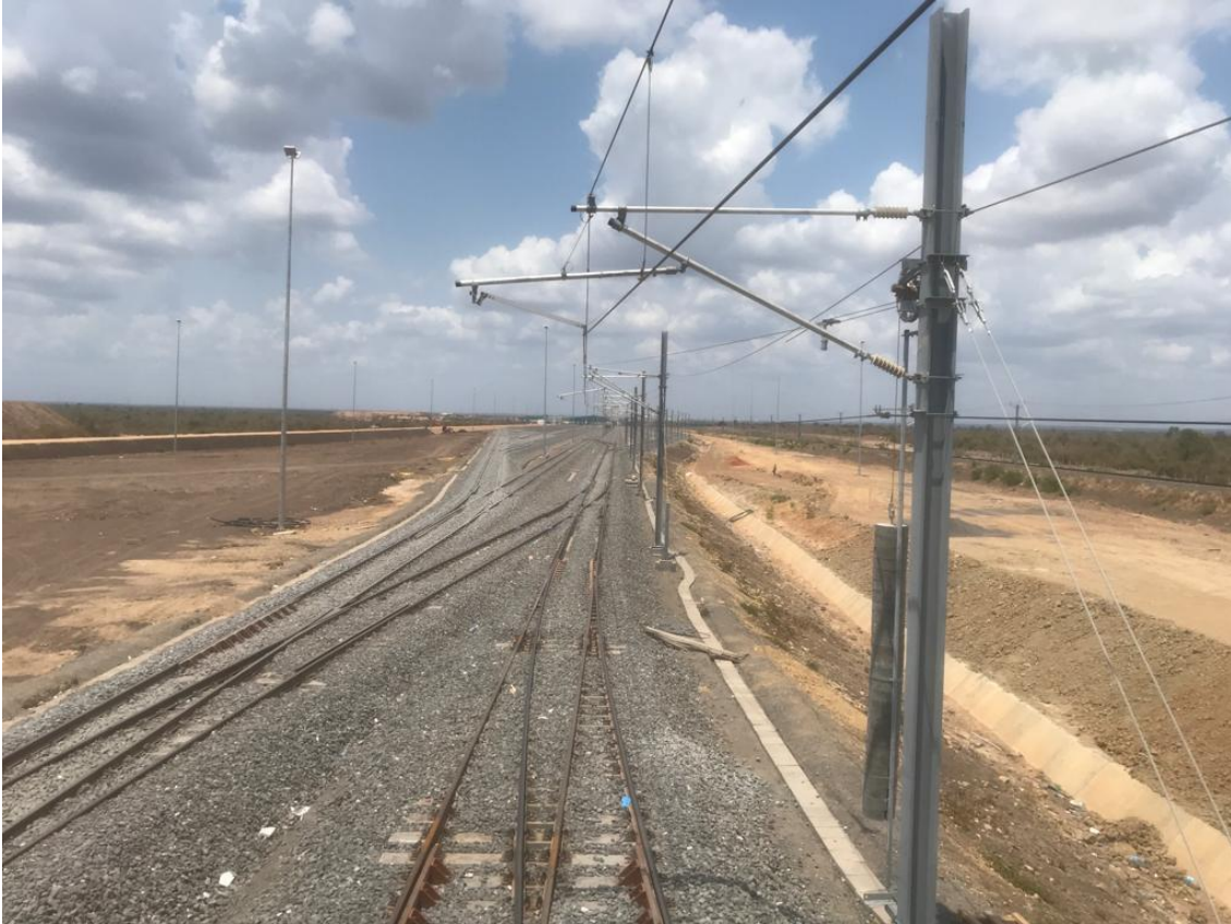
Şekil 1. Standart katener sistemlerine örnek olarak bir fotoğraf
