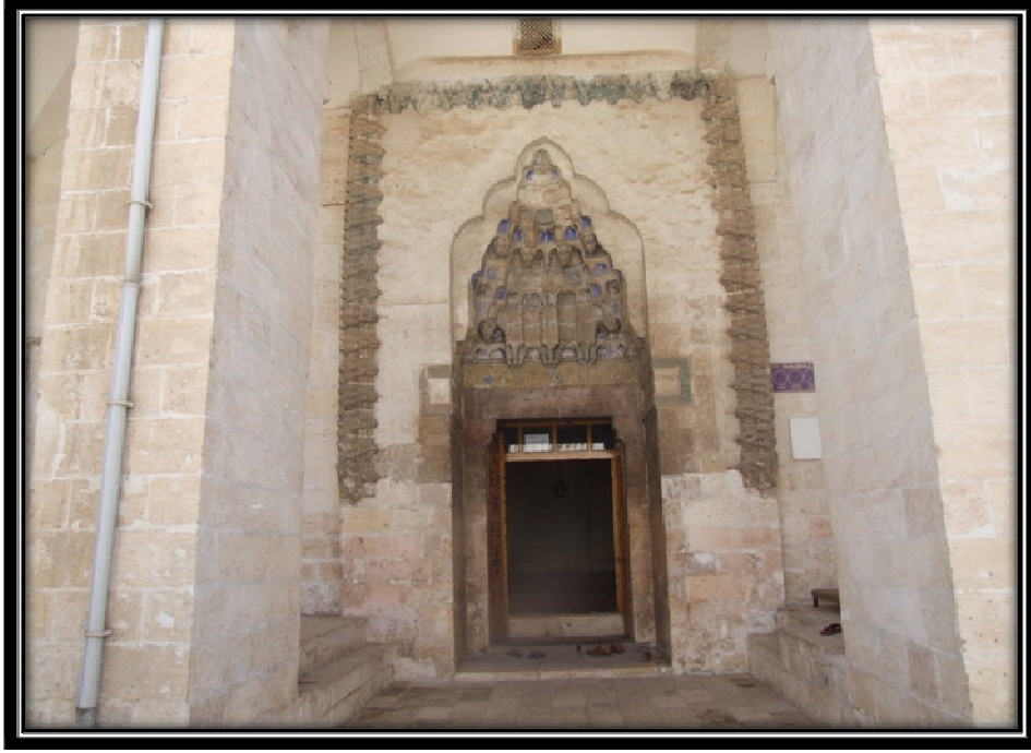
Foto.2 : Nimetullah Cami Taçkapısından Genel Görünüm.
