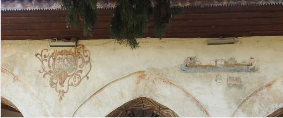
Fotoğraf 41: Caminin Kuzey Cephesi
