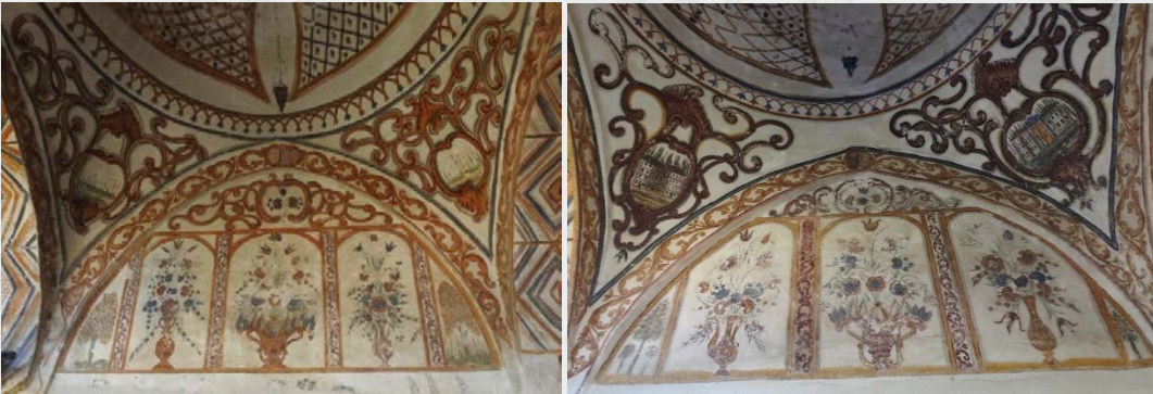
Fotoğraf 36-37: Kemerler Arasında Kalan Duvar Tezyinatı
