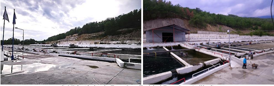
Şekil 2. Abaloğlu Eşen Çayı Tesisleri Eşen Çayı (orijinal)
