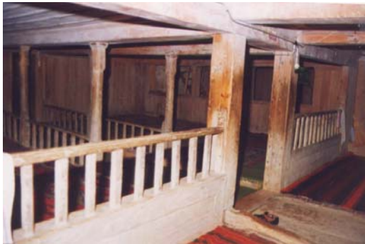
Foto.: 5- Giriş Bölümü ve Son Cemaat Yerinin İçerden Görünüşü
