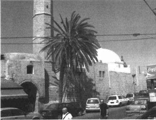
Foto. : 7- Mahmudiye Camii, güney cephe
