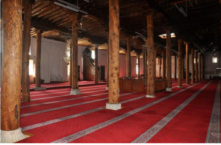
Şekil 1: Sivrihisar Ulu Camii harimden görünüm
