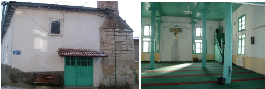
Şekil 27. Bodur Camii kuzey cephe
