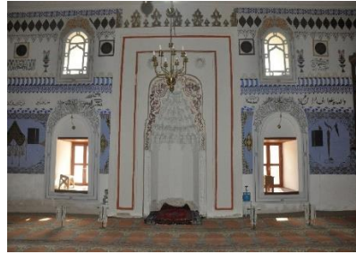
Şekil 16. Onarım sonrası mihrap
