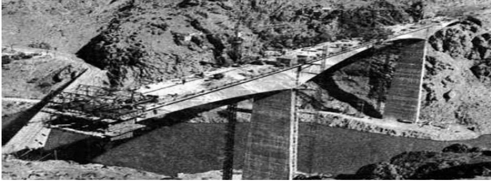
Şekil 2. Kömürhan Köprüsü'nün dengeli konsol yöntemi ile yapımı
