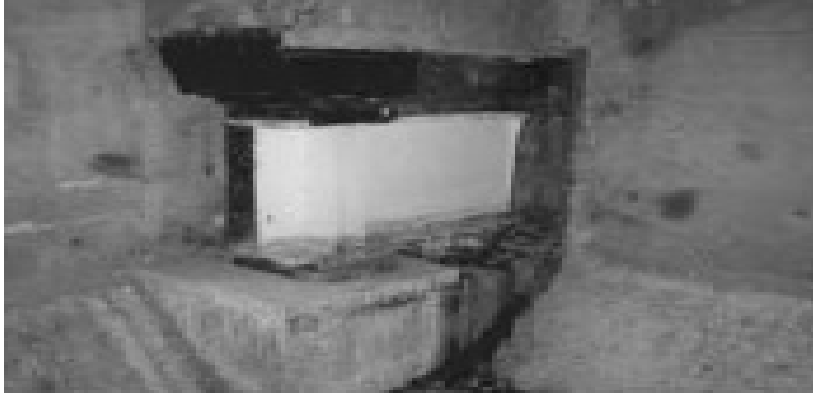
Şekil 4. Orta açıklık genleşme derzindeki mafsal düzeneği
