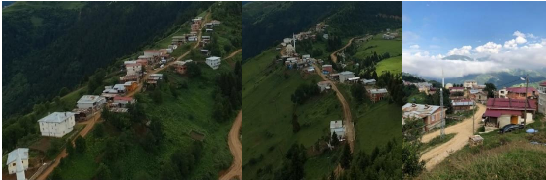
Şekil 12: Yerel Peyzajla Uyumsuz Betonarme Yapılaşma (Topcu, 2021)
