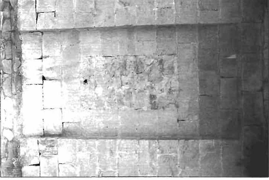
Resim 3. Huseyin Paşa Hamamı Doğu Cephesindeki Pencere
