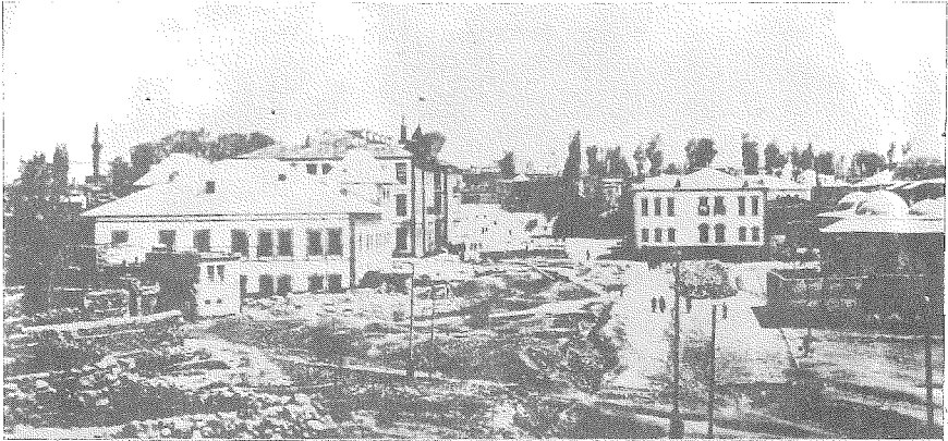
12. Lala Paşa Camii ve bugünkü belediyenin yerindeki eski Belediye binası.
