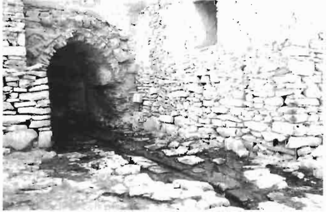
Fotoğraf-2 : Adır Çeşmesi Güneybatı Görünüşü
