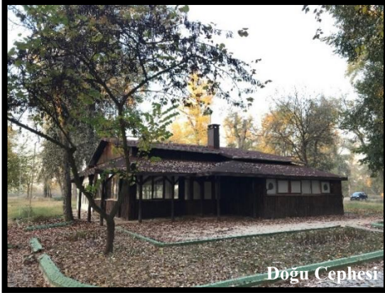
Şekil 4.11 Kafe-restoran yapısının doğu cephesi (Orijinal 2022)
