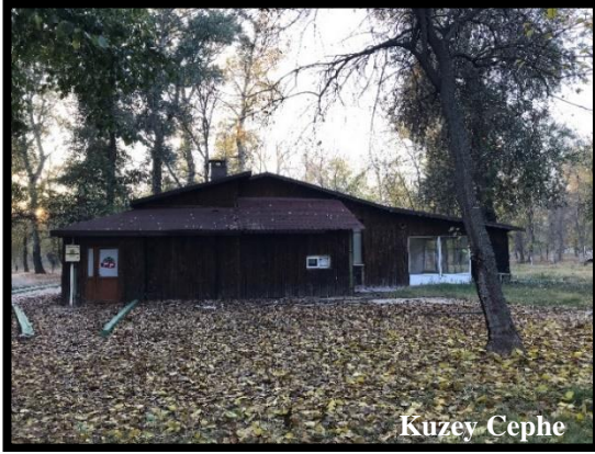
Şekil 4.10 Kafe-restoran yapısının kuzey cephesi (Orijinal 2022)
