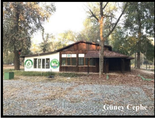
Şekil 4.9 Kafe-restoran yapısının güney cephesi (Orijinal 2022)
