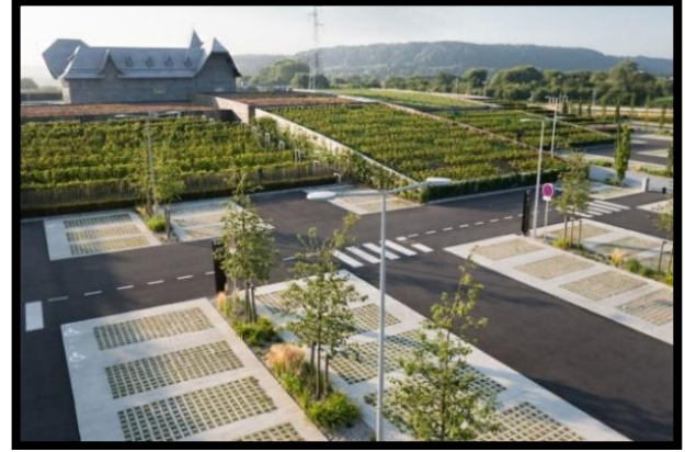
Şekil 4.3 Geçirimli asfalt ve yeşil altyapı ile oluşturulan otopark alanı (Anonymous 2014)
