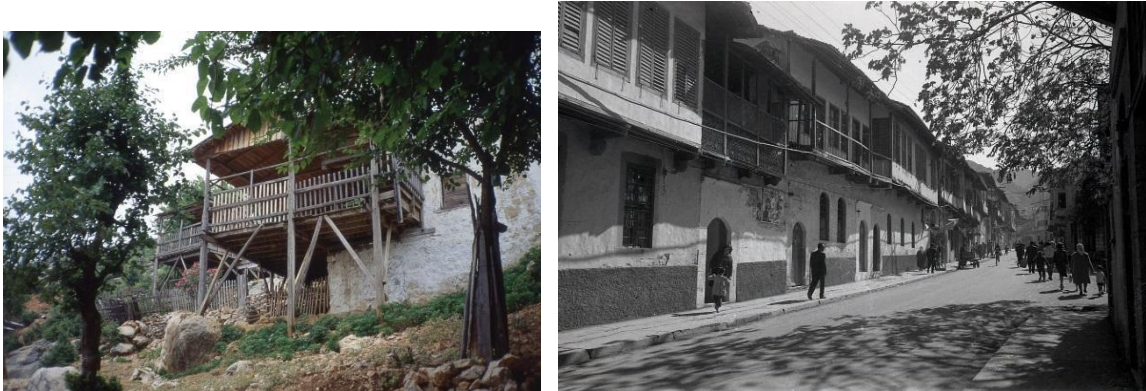
Şekil 36: Solda, Güney Anadolu'nun Toros dağlarındaki doğa ortamındaki yayla evlerinde çıkma tasarımı ve üst kat yorumu. (1990) Sağda, Bursa'nın önemli bir mahallesindeki sıkışık yerleşme ve "çıkma" tasarımı ile evlerin asıl önemli katının tasarımı.(1960)
