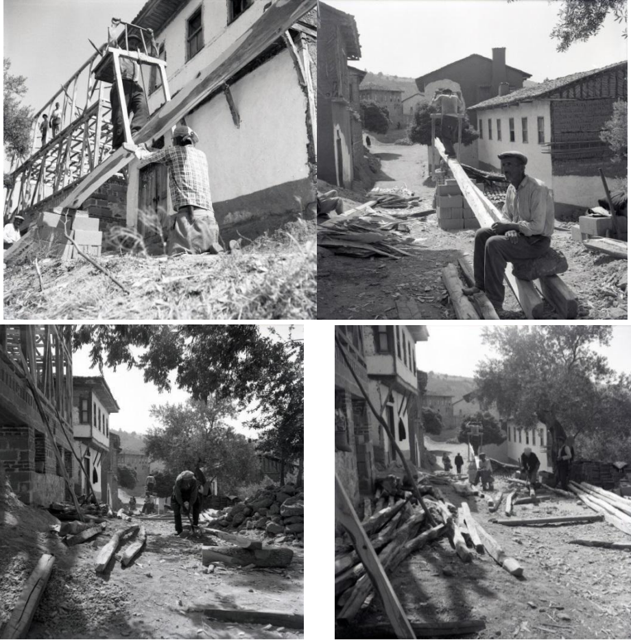
Şekil 32: 1960 yılında Bursa çevresinde bir ahşap ev inşa eden ustalar ve temel aletleri. (Ö. Küçükerman Arşivi)
