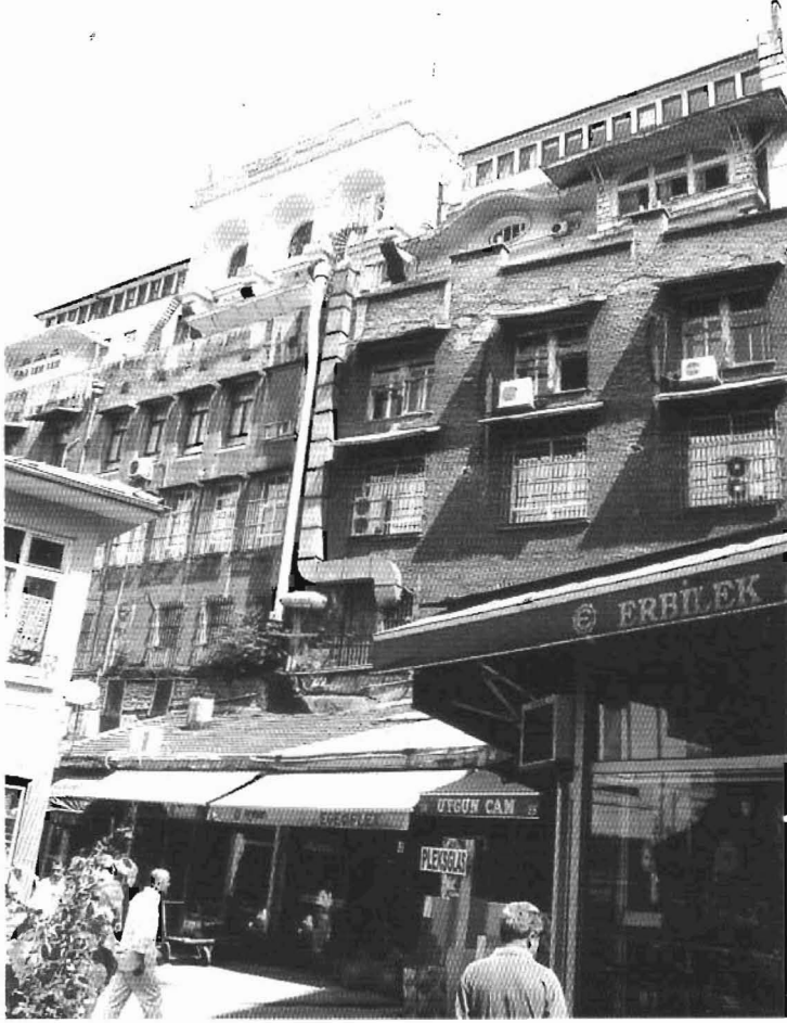
Resim 15 : Osmanlı Bankası Güney Cephesinden
