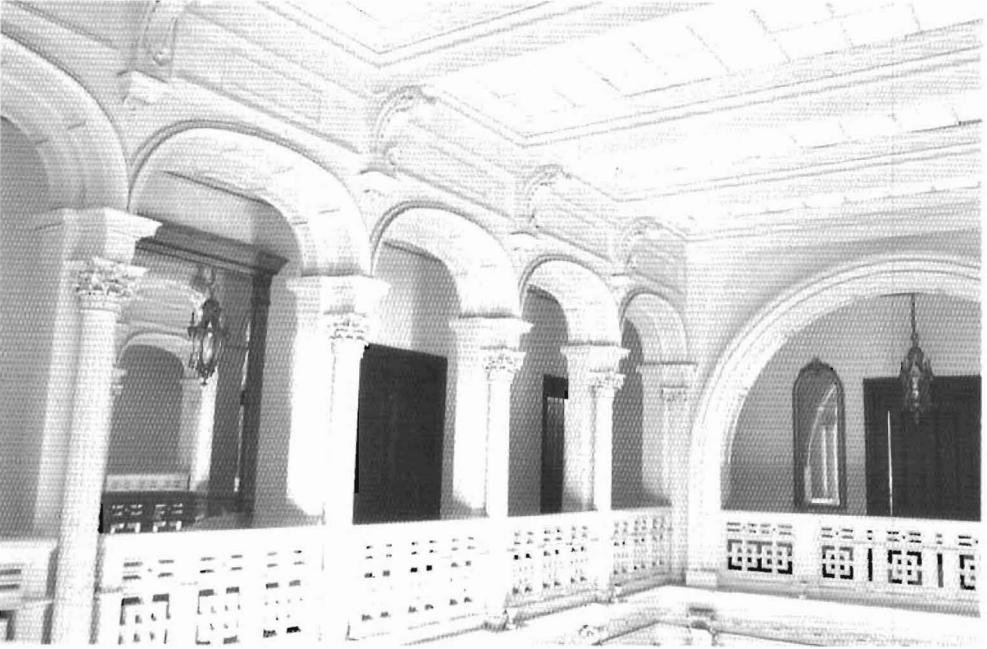
Resim 8 : Osmanlı Bankası Aydınlık Boşluğundan
