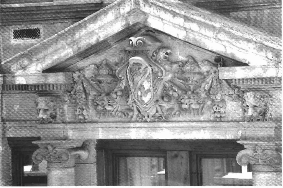
Resim 13 : Osmanlı Bankası Cephesindeki Üçgen Alınlıkların Rölyeflerinden
