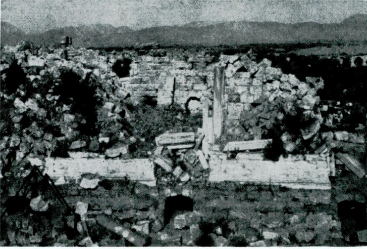
Res. 18 — Sahne binası cephesinin bugünkü durumu
