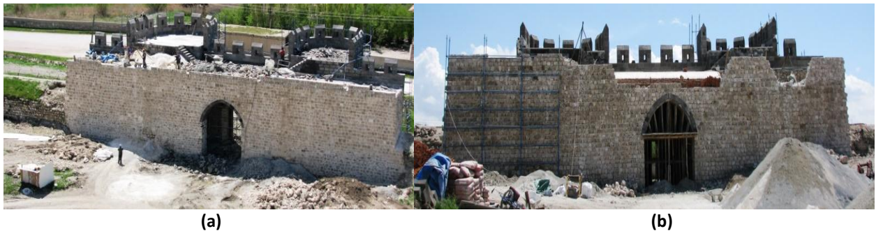
Şekil 32. Saray Kapısı (a) Onarım çalışması görünüşleri; (b) Onarım çalışması görünüşleri (Kaynak: (a,b) Yazarın kişisel arşivi, 2012).
