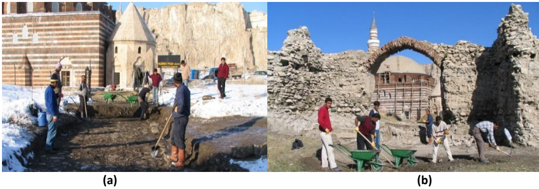
Şekil 25. Saray Kapısı (a)Kuzey cephe kazı çalışmaları görünüşü; (b) Saray Kapısı güney cephe kazı çalışmaları görünüşü (Kaynak: (a,b) Yazarın kişisel arşivi, 2006).
