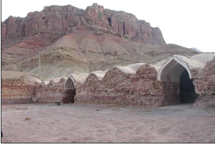
Foto.4 Kervansaray'daki onarım çalışmaları (2009).
