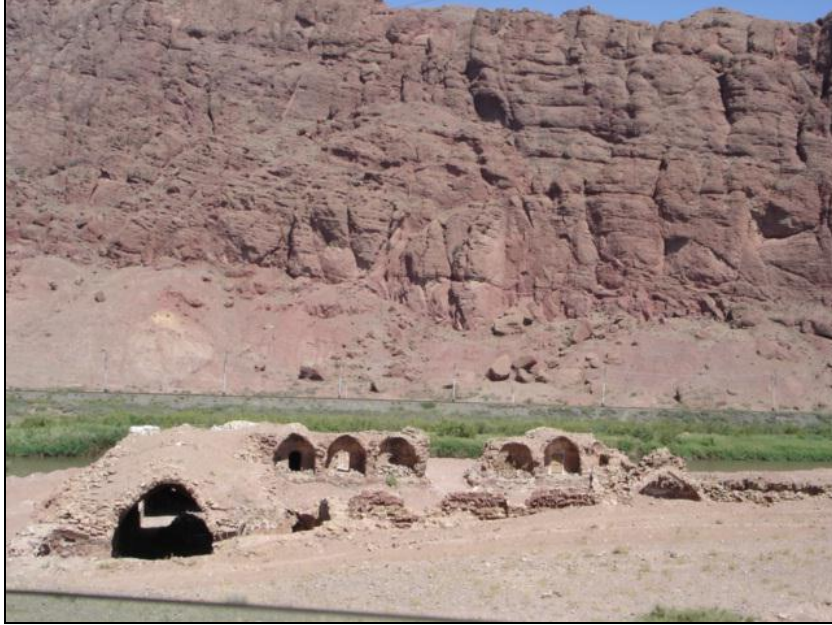
Foto.3 Kervansaray'ın 2005'teki durumu.
