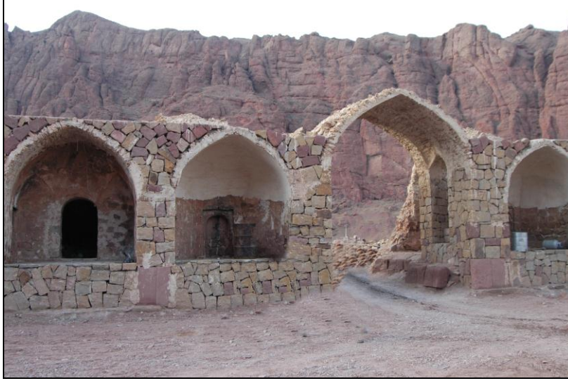
Foto.5 Kervansaray'daki onarım çalışmaları (2009).
