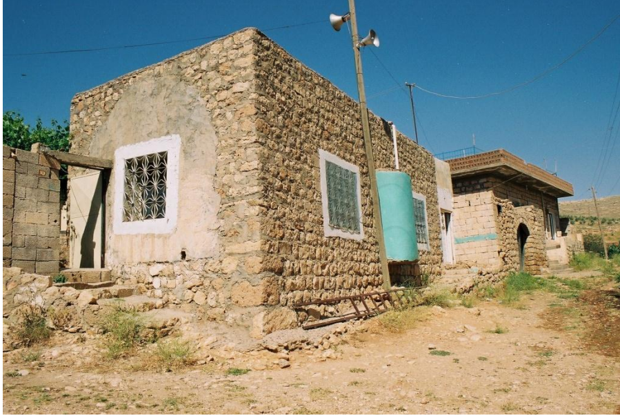
Foto: 13- Ayaz Köyü Camii'nin Genel Görünüşü.
