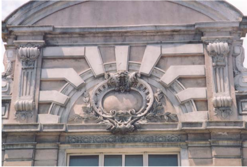
Foto.: 10- Galata Rüşumat (Gümrük) Binası Güneybatı (Deniz) Cephesi Kapı Frontonlarından.
