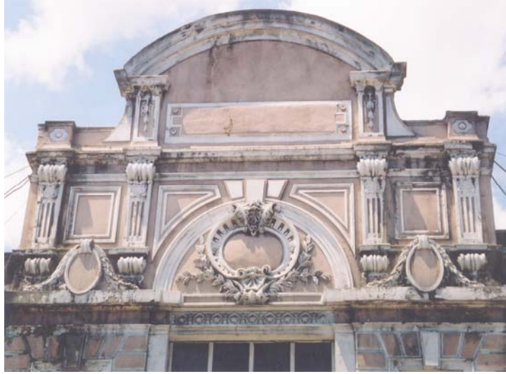
Foto.: 8- Galata Rüşumat (Gümrük) Binası Güneybatı (Deniz) Cephesi Kapı Frontonlarından.
