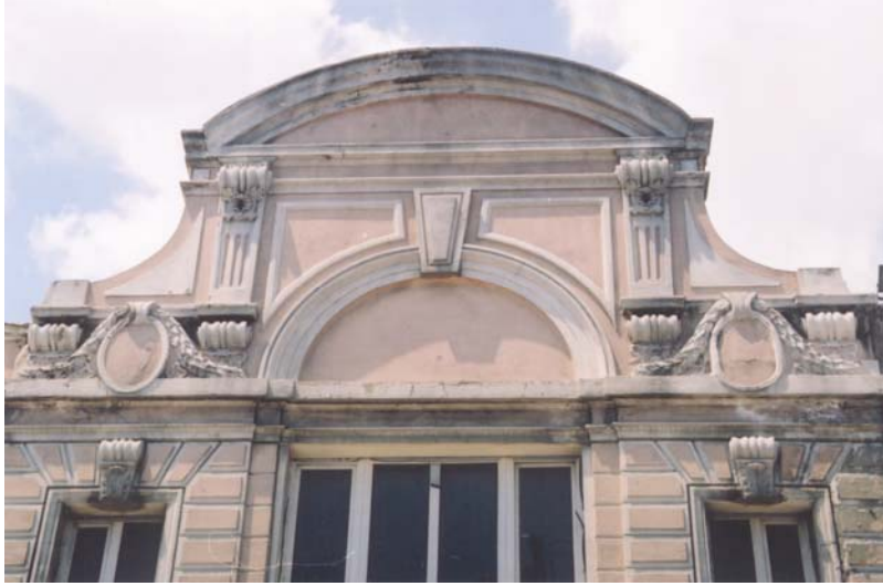
Foto.: 9- Galata Rüşumat (Gümrük) Binası Güneybatı (Deniz) Cephesi Kapı Frontonlarından.
