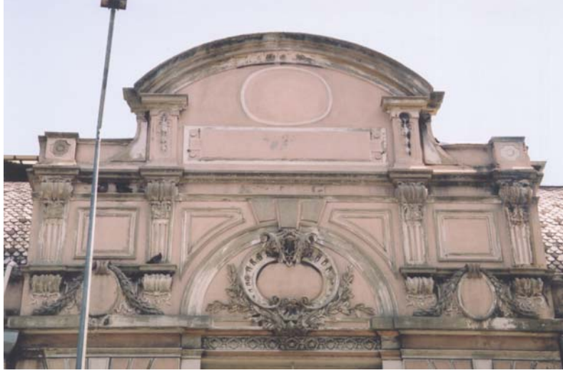
Foto.: 11- Galata Rüşmat (Gümrük) Binası Kuzeydoğu (Kemankeş Caddesi) Cephesindeki Ana Giriş Frontonundan.
