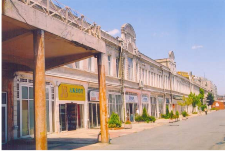
Foto.: 1- Galata Rüsümât (Gümrük) Binası Güneybatı (Deniz) Cephesinden Ayrıntı.
