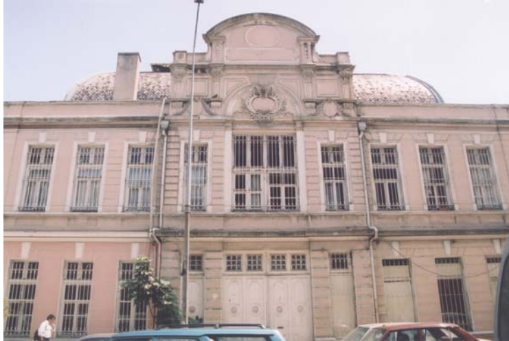
Foto.: 3- Galata Rüşumat (Gümrük) Binası Kuzeydoğu (Kemankeş Caddesi) Cephesindeki Frontonlu Ana Giriş.
