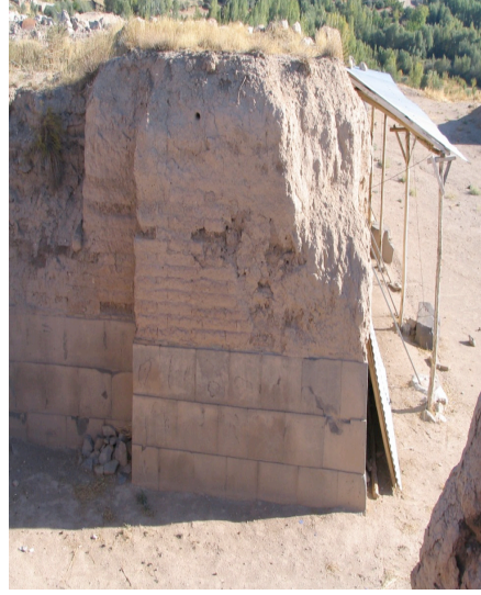
Foto. 2: Ayanıs Urartu Urartu Kalesi Kerpiç Görünüşü.
