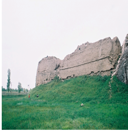
Foto. 20: Van Kalesi Bat Teknięi ile İnşa Edilmiü Kuzey Burcu Görünüüü.
