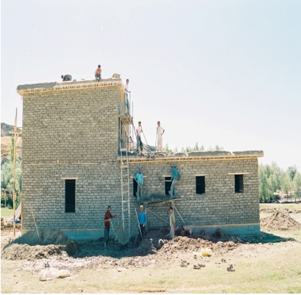
Foto. 15: Örnek Van Evi İnşaat Görünüşü.
