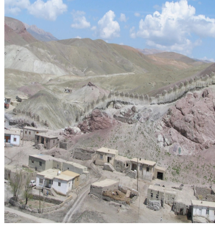
Foto. 22: Hoşap Kalesi Bat Tekniği ile İnşa Edilmiş Kuzey Sur Görünüşü.
