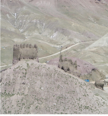
Foto. 21: Hoşap Kalesi Bat Tekniği ile İnşa Edilmiş Burcu Görünüşü.
