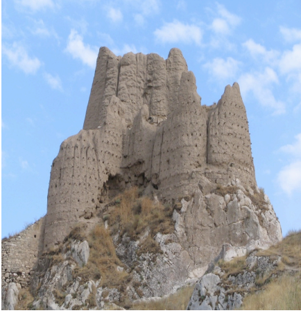
Foto. 19: Van Kalesi Bat Teknięi ile İnşa Edilmiü Burcu Görünüüü.
