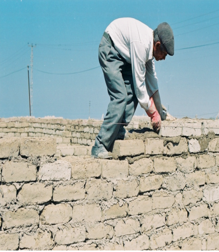
Foto. 11: Kerpiçin Duvarda Kullanım Görünüşü.
