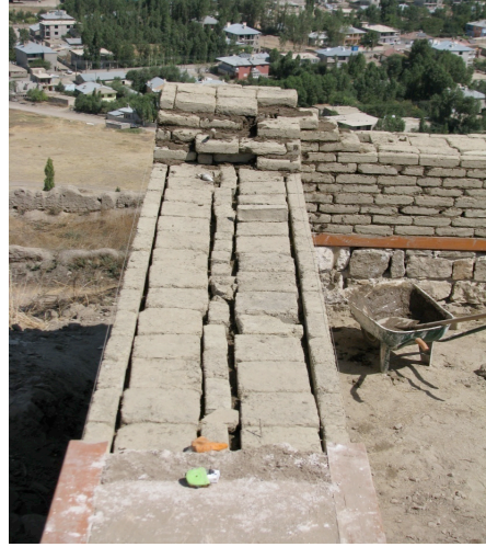
Foto. 12: Kerpiçin Duvarda Kullanım Görünüşü.
