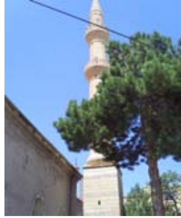
Foto. 12: Camiye Sonradan Eklenen Minare
