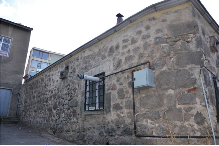
Foto. 24: Restorasyonlar Sonrası Mektebin Doğu Cephesi
