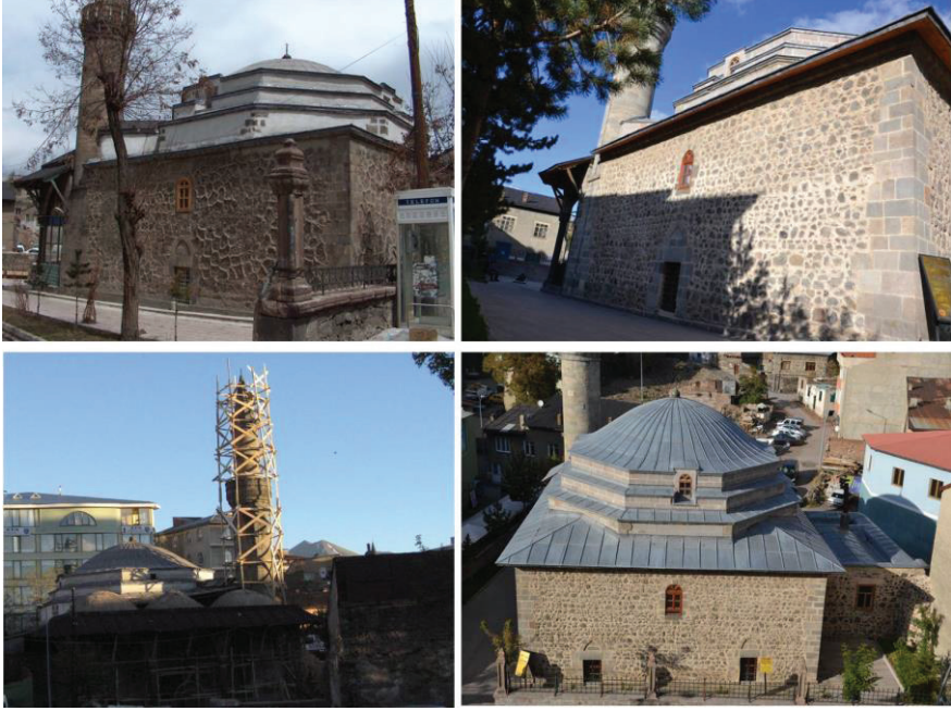
Foto. 28: Caferiye Camii'nin Restorasyon Öncesi ve Sonrası Dış Cephe Görüntüleri
