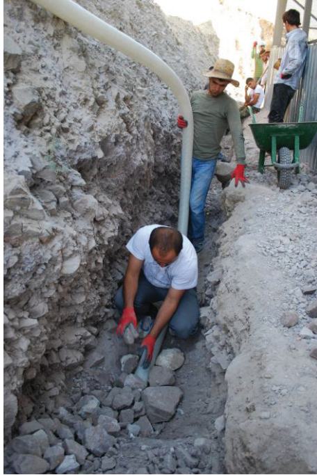
Foto. 14: Kilise Etrafına Döşenen Drenaj Borusu
