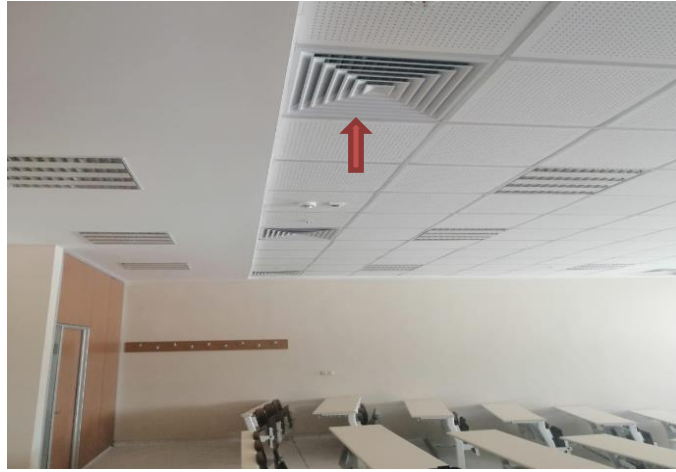
Şekil 13. Mühendislik ve Mimarlık Fakültesi sınıf ve ofislerinde kullanılan tavan tipi difüzörler
