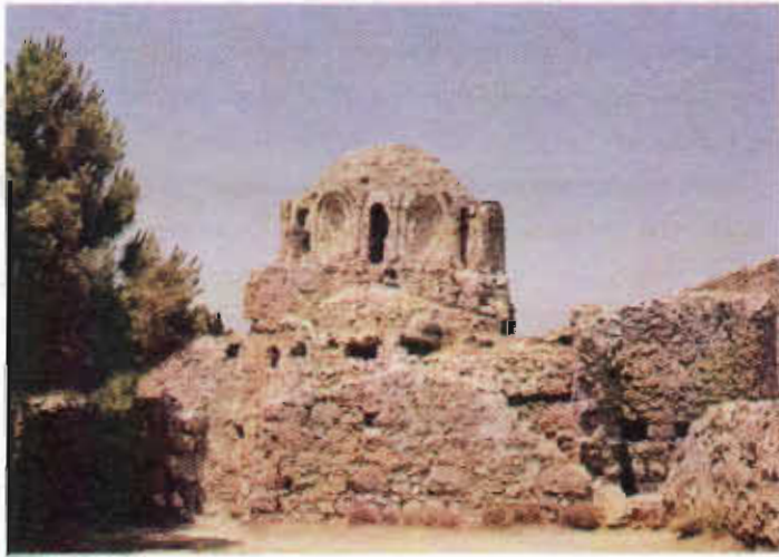
Resim 2. Eski Kilisenin Kuzey ve Kuzeydoğu Cephesi
