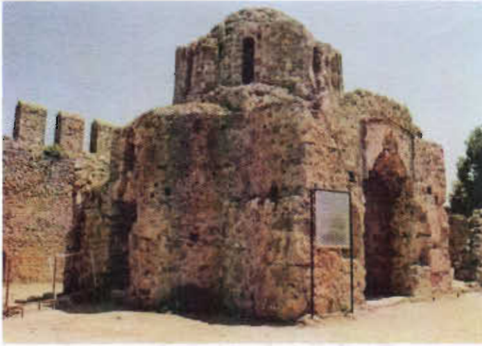
Resim 3. Eski Kilsenin Güneybatı Cephesi
