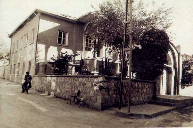
Resim 5. 1930'lu yılların sonunda trahomlu öğrencilere ayrılan ve bu nedenle halk arasında Trahom Mektebi olarak bilinen Derme İlkokulu. Gazeteci Celal Yalvaç Arşivi'nden, Celal Yalvaç'ın izni ile.
