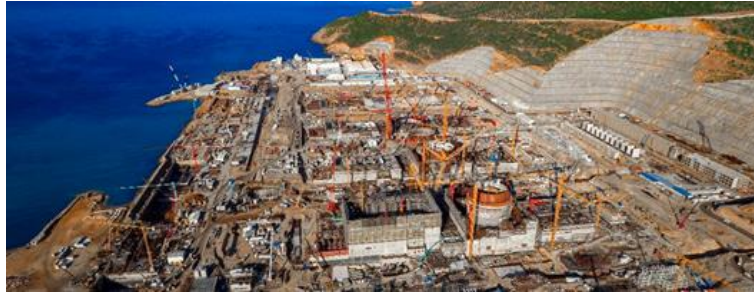
Şekil 2. Akkuyu Nükleer Santral İnşaatı (Akkuyu Nükleer A.Ş.)
