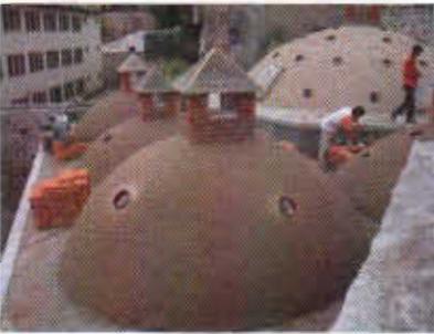
Resim 11: Hamamın kubbelerinin toprakla Svanışı
