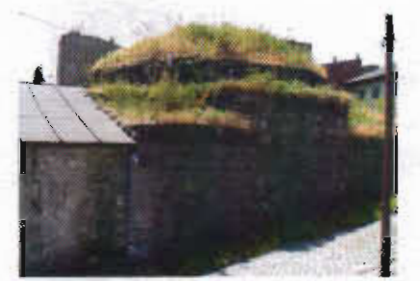
Resim 4: Hamamın onarım öncesi dış görünüşü
