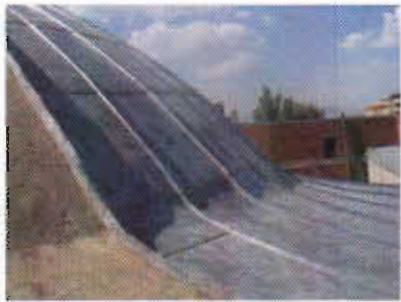
Resim 12: Kubbelerin sac kaplanması
