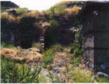
Resim 3: Hamamın onarım öncesi dış görünüşü
