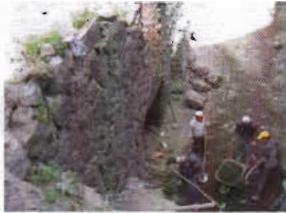
Resim 18: Restorasyon çalışmaları sürerken
