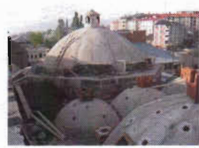
Resim 10: Hamamın örtüsündeki restorasyon
