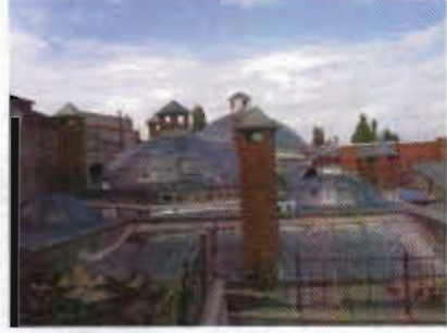
Resim 14: Hamamın örtüsünün genel görünüşü
