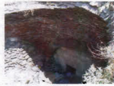
Resim 6: Hamamın yıkılan kubbesi
