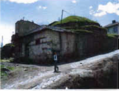
Resim 1: Saray Hamamının onarım görünüşü
