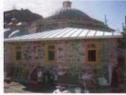
Resim 16: Abşap pencerelerin yenilenişi
