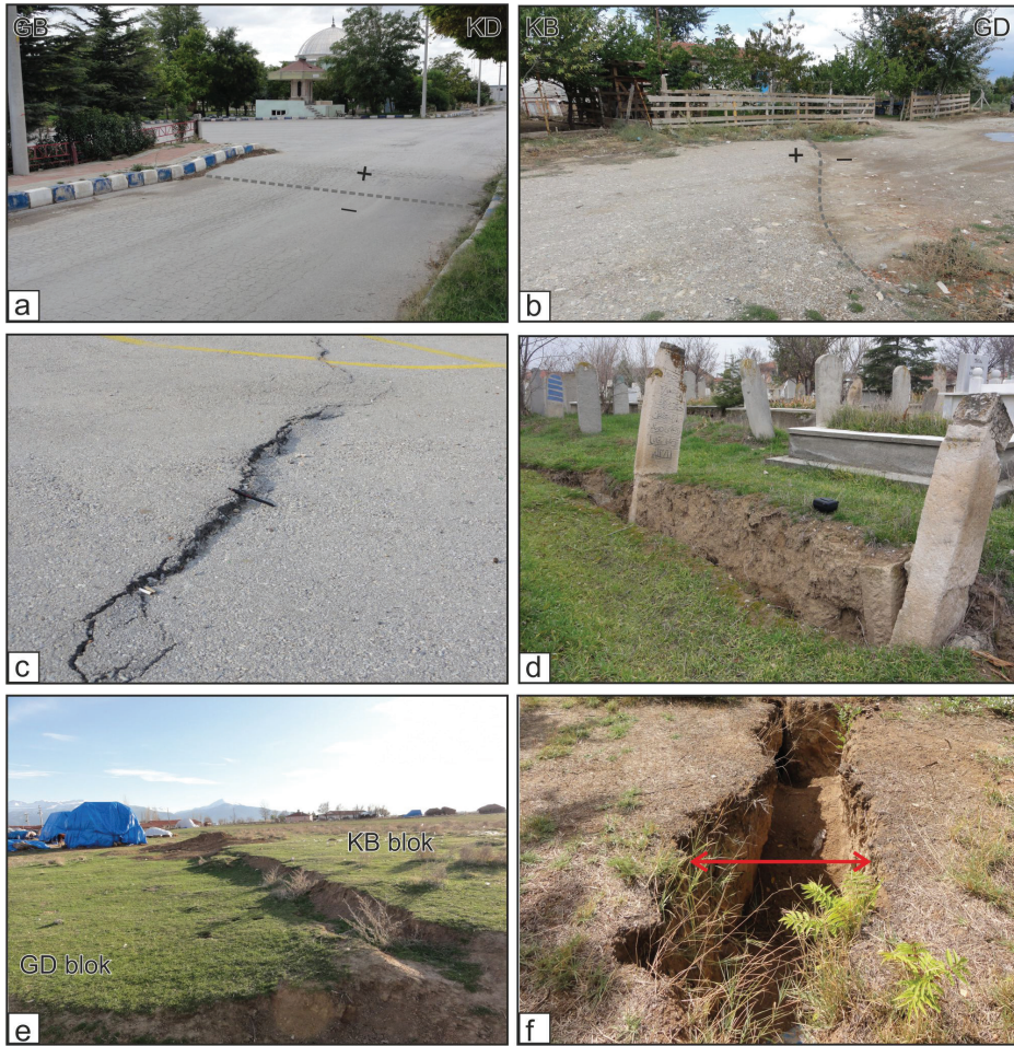
Şekil 8. Bolvadin yerleşim alanı içerisinde gözlenen yüzeysel deformasyonları. a-b) Akçan parkı ve yakın kuzeyinde yollar üzerinde gözlenen yüzeysel faylanmaları, c) Bir okulun bahçesindeki asfalt zeminde gözlenen çizgisel gidişli deformasyonlar, d) Bolvadin mezarlığında gözlenen yüzeysel faylanması, e) Bolvadin Abdülvahab Gazi Türbesi civarında gözlenen yüzeysel faylanması f) Bolvadin mezarlığı güneybatısında gözlenen yüzeysel yarığı
