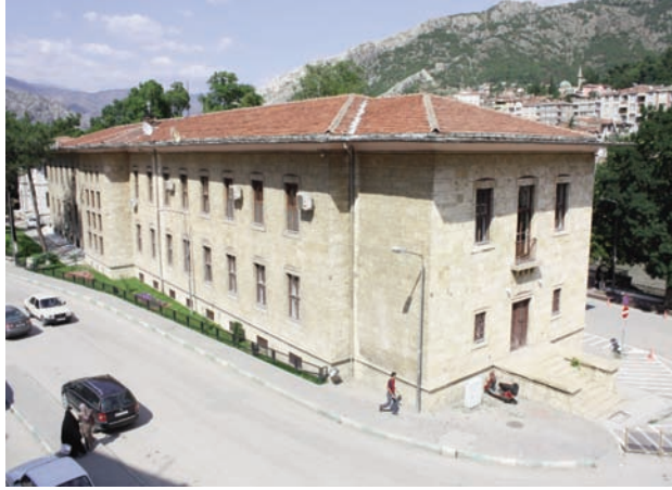
Resim 12. Amasya Hükümet Konağı, arka cephesi (Nurcan Yazıcı, 22 Temmuz 2009).
