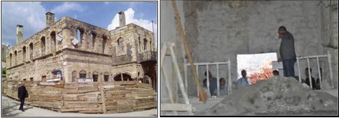
Şekil 5. Ergani Hükümet Konağı restorasyon çalışması (Tanrikulu, Aksoy: 2012)
