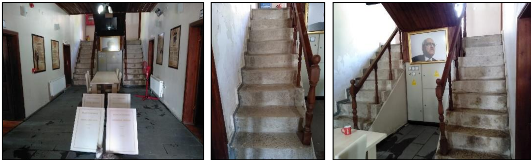
Şekil 18. Merdiven bölümü fotoğrafları (2022)
