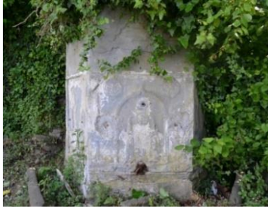
Şekil 28-29. Hacı Veli Camii Çeşmesi
