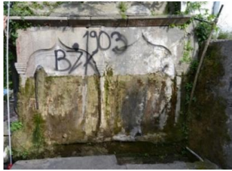
Şekil 36. Karadeniz Mahallesi Sokak Çeşmesi
