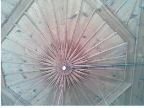
Fotoğraf 12: Çavuşoğlu Konağı birinci kat güneybatı oda tavanı (Fotoğraf: Müslüm Aydın)
