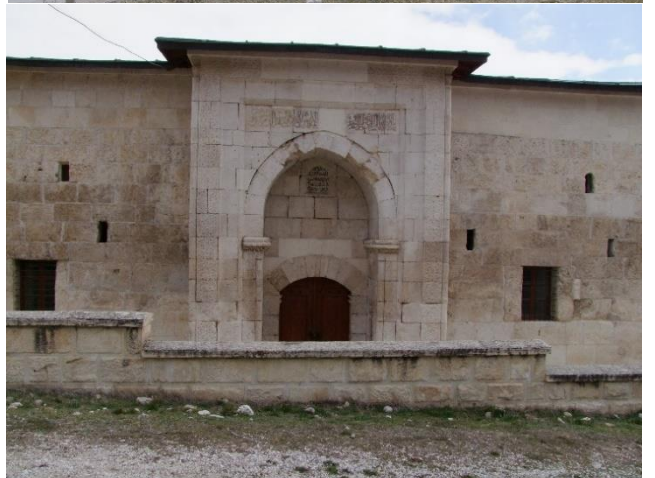
Şekil 2. Yapının Kuzey-Batı cephesi
