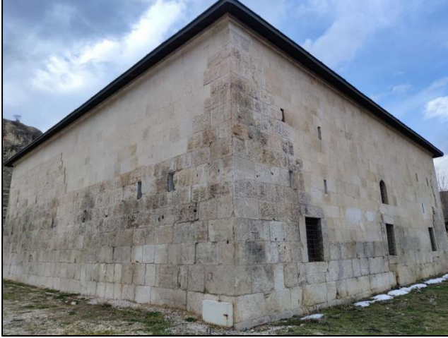
Şekil 3. Yapının Güney-Doğu cephesi
