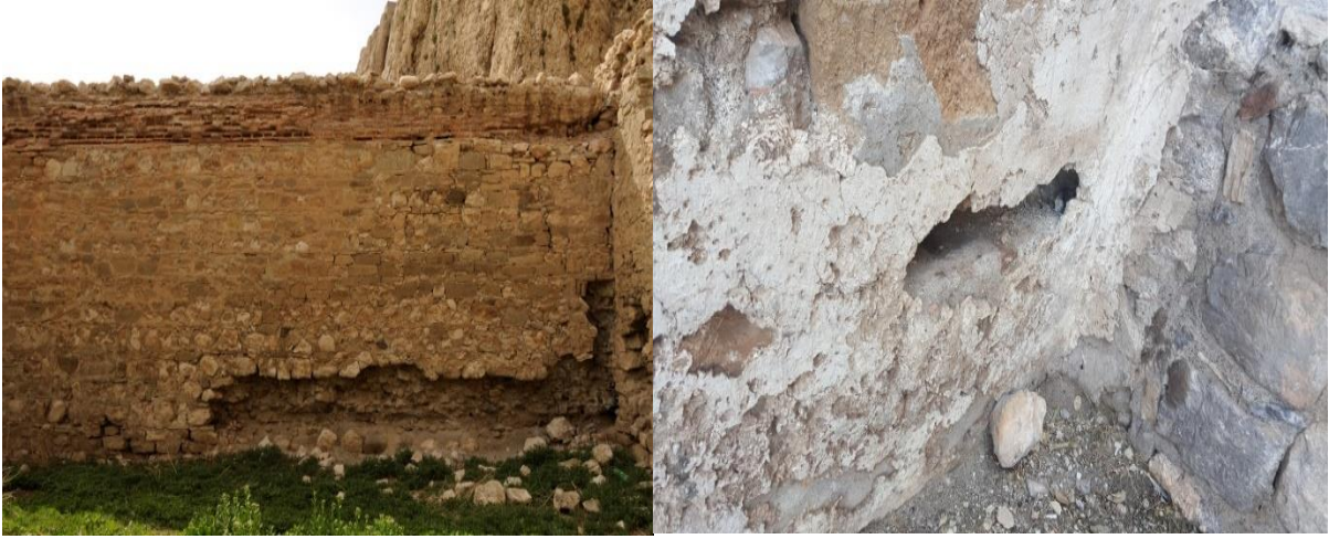
Şekil 49,50. Miri Ambarı Beden Duvarları Ahşap Hatıl Tomruk Görünüşleri (Kaynak: Ş. Öztürk, 2010).
