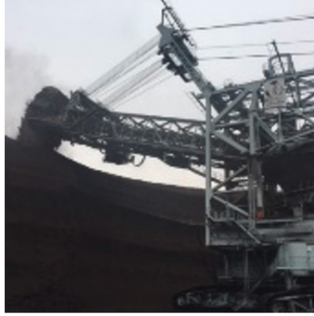
Şekil 1. Afşin-Elbistan linyit havzası Kışlaköy açık işletmesinde DKE görünümü
