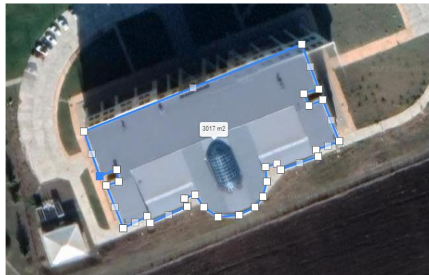
Şekil 3. Kütüphane çatı alanı Figure 3. Library roof area
