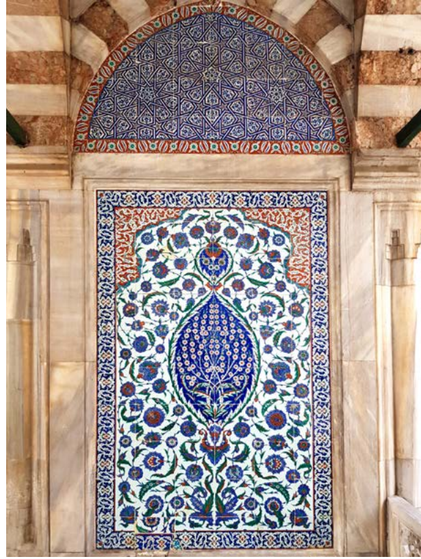
Görsel 4 II. Selim Türbe- si revaktaki sağ panonun özgün mevcut hâli
