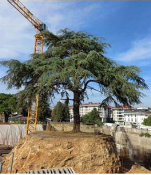
Şekil 3. 2 nolu ağacın kök bölgesinin kazılması ve 1 nolu ağacın kasa tabanının oluşturulması
