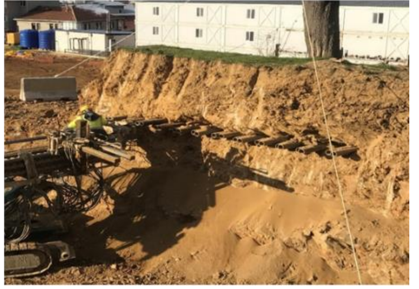
Şekil 3. 2 nolu ağacın kök bölgesinin kazılması ve 1 nolu ağacın kasa tabanının oluşturulması
