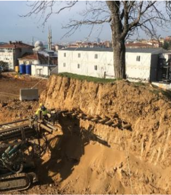
Şekil 4. Kasalama çalışması
