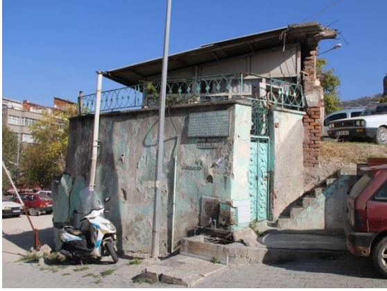
Fotoğraf 3. Türbenin batı cephesi
