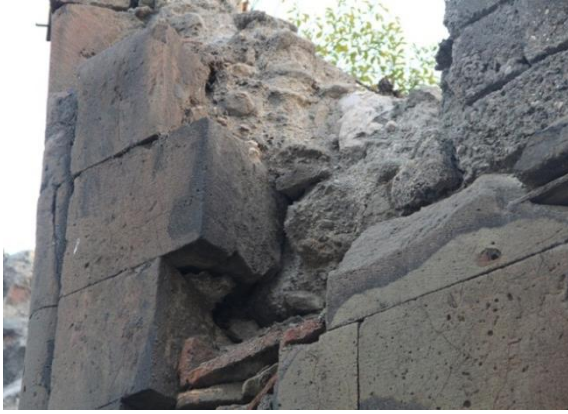
Fotoğraf 9. Kuzey cephe kaplama taşları
