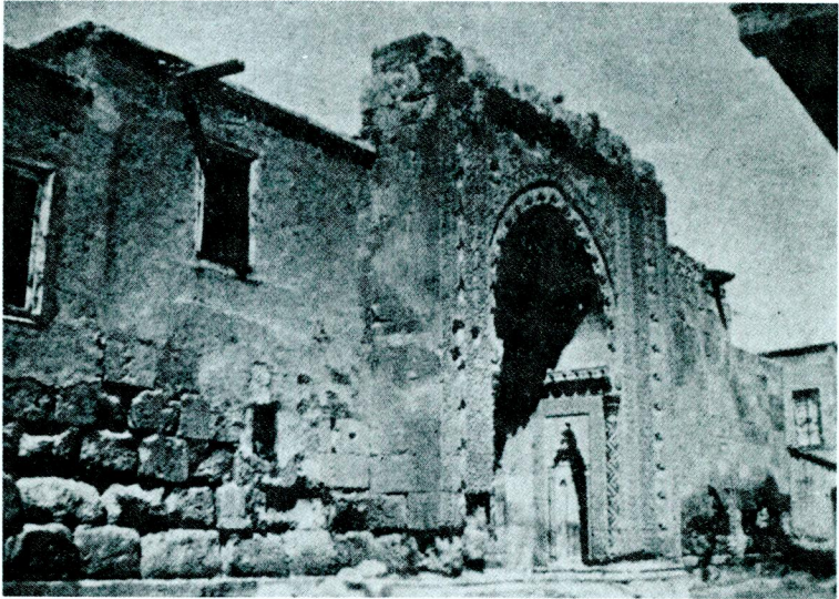
Res. 21 — Konya Sırçalı Medrese Cümle kapısının onarımdan önceki hali.
