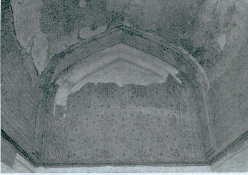
Res. 18 — Konya Sırçalı Medrese. Eyvanın içi ve batı duvarı.
