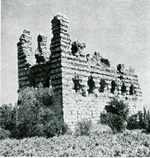
Res. 1 b — Kasaba tarafındaki cephe.
