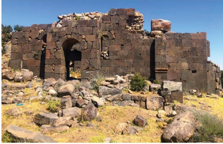
Fotoğraf 7 : Kara Kilise, güney cephe (Uyar, 2021: 38)
