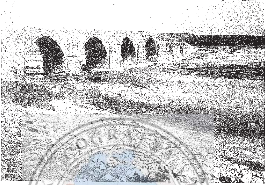
3 — Aras ırmağı üzerinde Çobandede köprüsü Eski yollar üzerinde yapılmış taş köprüler arasında mimarlık bakımından değeri olanlar vardır. Aras'ın yukarı kısmında, Pasinler ovasının doğusundaki Çobandede köprüsü bunlardandır.
